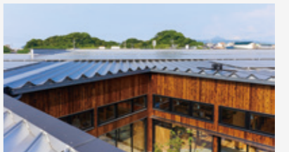
「無印良品 唐津」太陽光発電設備
